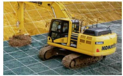
施工完成図面の3次元データの活用でICT建機は自動制御で動き、未熟練者でも難しい作業をこなせる。
