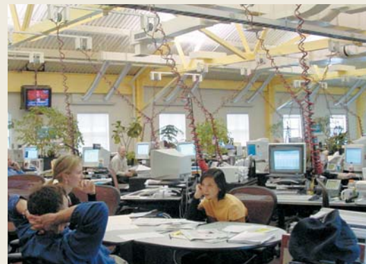
SEIのオフィス。天井からネットワーク接続ケーブルと電源ケーブルがぶら下がる。
