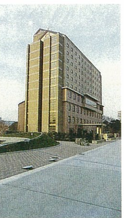
ヒューマンリンク運営のセミナーハウス「フォーシーズン」(世田谷区船橋)。研修所の設備とホテル並みのリラクゼーションを兼ね備えた新感覚の研修所として注目されている。
