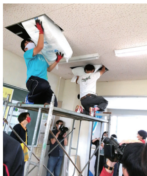
2025年3月15日、別所線増便の初日に手を振るイベントを開催(写真左)。2012年3月、相乗りくんの第1号が発電を開始(写真左下)。白馬高校でのワークショップ。生徒たちが天井に断熱材を入れるなど、作業に参加した(写真右下)。
