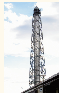
無重力実験施設の内部（上）と外観（左）。てっぺんから測定物を入れたカプセルを落とし、落下中の無重力状態時のデータを測定する。同様の施設はドイツにもう1つあるだけだ。
