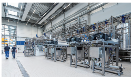
フロットヴェグは、バイエルン州フィルスビーブルクの森に囲まれた美しい土地にある(写真上)。2026年に開設したプロセスセンターでは、実際の操業条件に近い環境でテストできる(写真下)。
