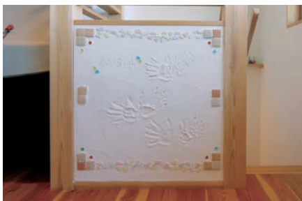
左官の指導のもと、家族総出で塗った守矢邸の小ぶりの壁。材料は珪藻土で、家族6人の手形がついている。
